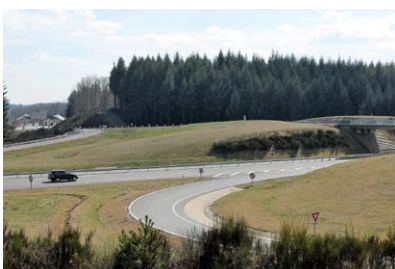
Échangeur autoroutier A89
