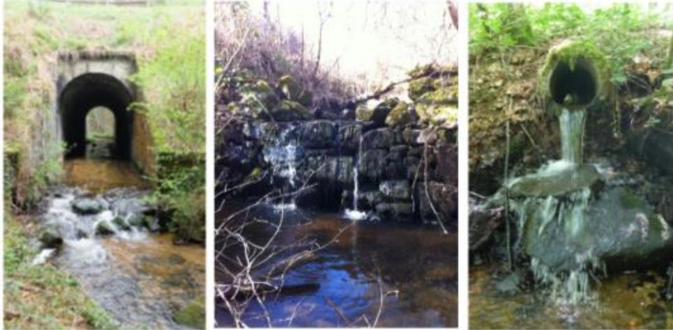
Figure 8 : Exemples d'ouvrage infranchissable pour la faune piscicole. De gauche à droite : pont, seuil et buse
