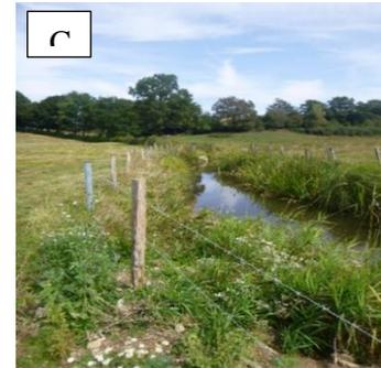
Figure 12 : Exemple d'aménagements réalisés dans le cadre de travaux de mise en défens de berges. A : Descente aménagées : B : Passage à quai et C : Mise en défens des berges grâce avec de la clôture barbelée.
