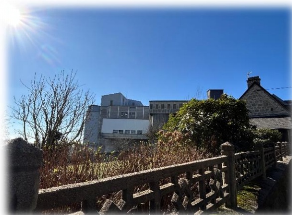
Vue sur la minoterie depuis la RD 1089
