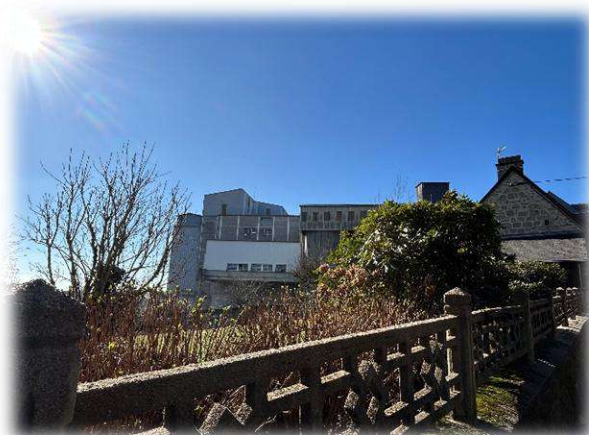
Vue sur la minoterie depuis la RD 1089
